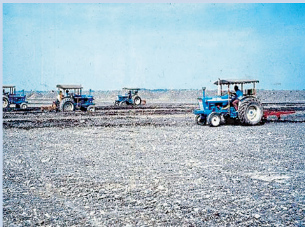
台糖花蓮河川地開發工程施工情形。
