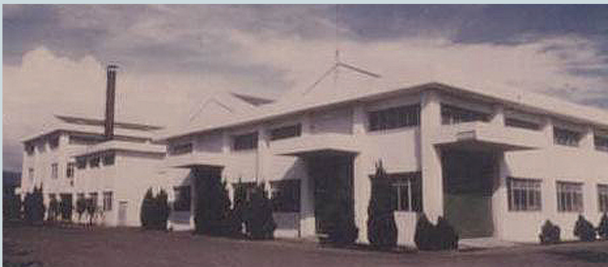
彰化工廠廠房。
