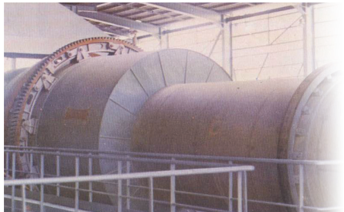
中國磷業公司磷酸鈉冷卻工程。
