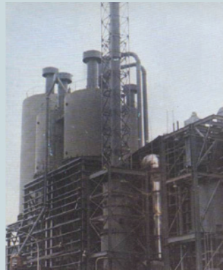
中磷公司儲油庫。
