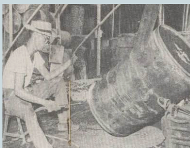
油桶焊補漏孔作業（民國51年）。
