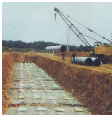
瓦斯地下管線工程排放管施工。
