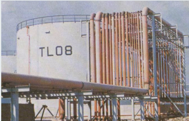
中油公司高雄煉油廠管線工程。
