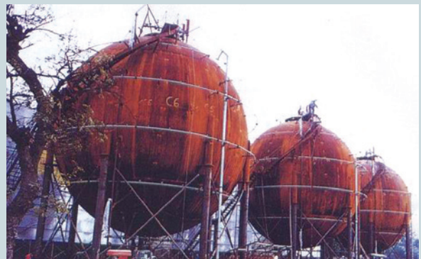
建造中之1,000公秉天然氣球槽外觀。
