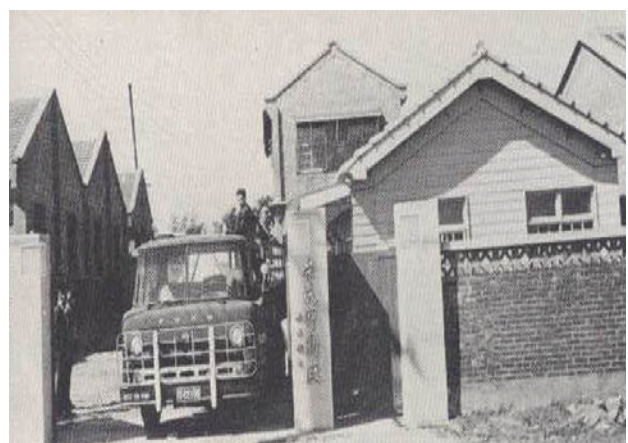
位於板橋市埔墘之廠房大門（民國53年）。
