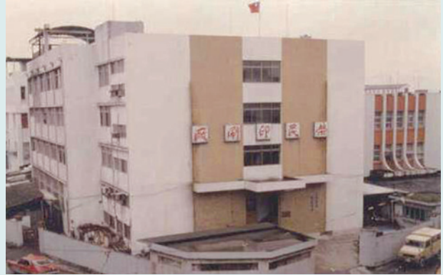
位於臺北市西園路之廠辦大樓。
