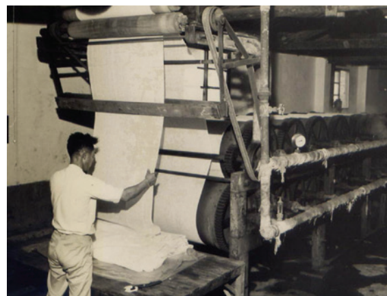
於景美廠之衛材場紗布生產設備。
