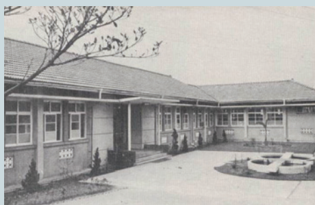
榮民醫院聯合製藥廠廠房外景（民國53年）。
