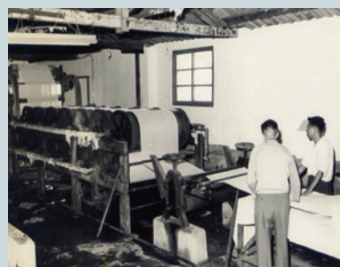
景美廠生產紗布之設備。
