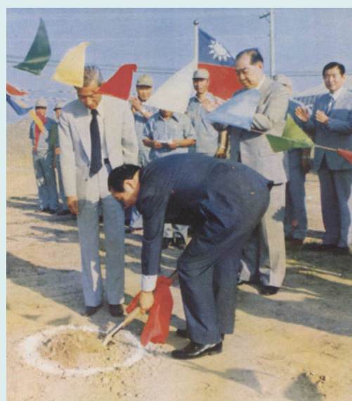
趙聚鈺主委主持興建楠梓工廠破土（民國69年）。
