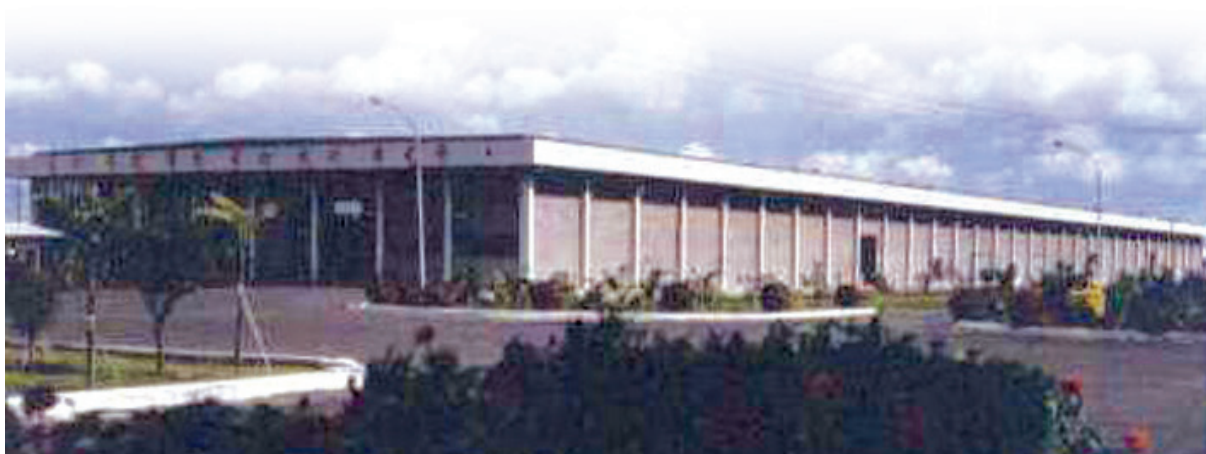
楠梓工廠砂紙布生產廠房外觀。
