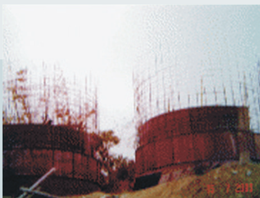
創建時興建廠區蓄水池。
