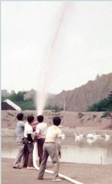
室外消防栓測試及演練。
