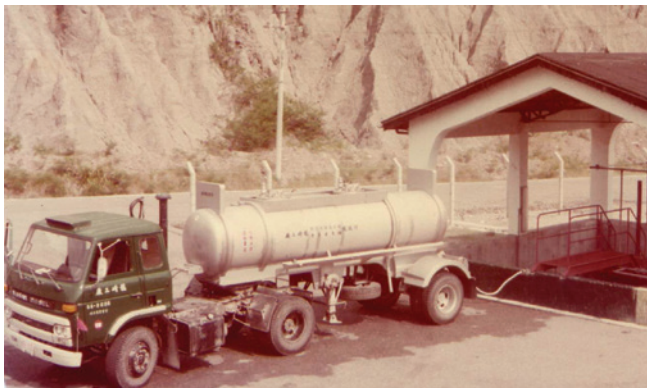
硝甘炸药原料混酸槽车及储酸池。
