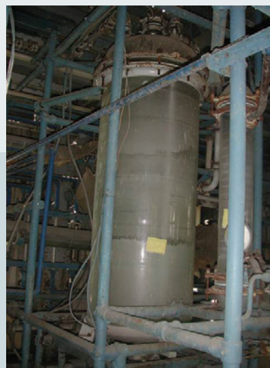
酸場生產線濃硫酸槽。
