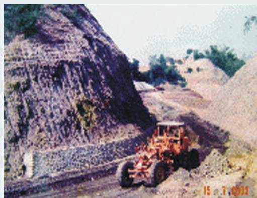
創建時興建廠區道路。
