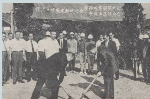
第五處劉慶生處長（前左）主持建廠破土（民國60年）。
