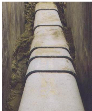
堆設預鑄電纜管之工地現場。
