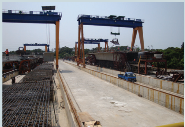
於廠區生產預鑄水泥節塊一景（100年4月27日）。
