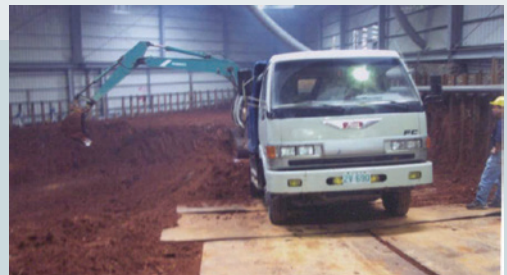
整治之土壤先隔離再開挖及運送焚燒處理。
