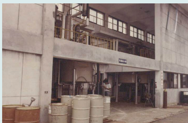
有機磷產品廠房設備。
