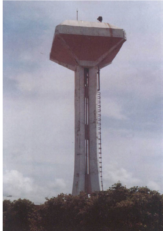
廠區及附近之地標—給水塔設施。
