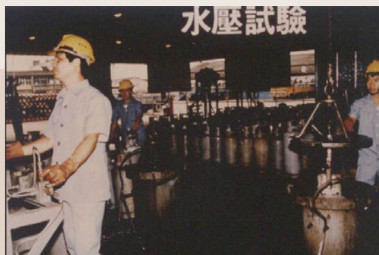
鋼瓶之水壓試驗。
