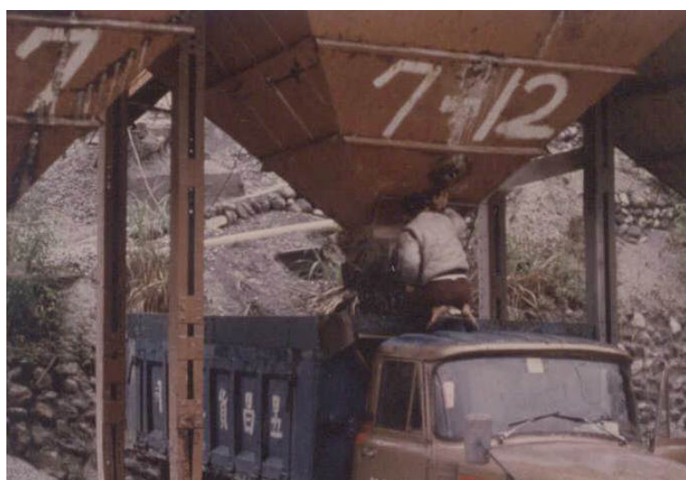
開採之石材運裝設備。
