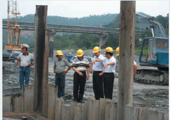
楊郁湜主任（右2）視導三地門橋樑工程。
