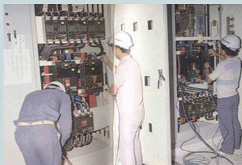
大樓配電工程。
