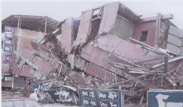
921大地震房屋倒塌。
