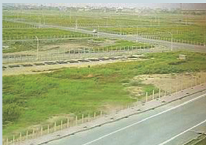
工業區路面整建。
