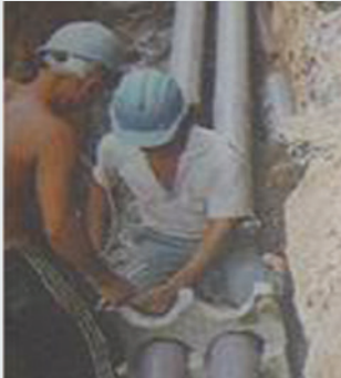
埋設台電電纜管。
