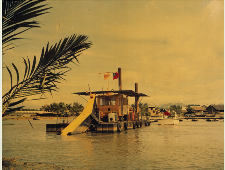
榮工挖泥船在越南進行湄公河三角洲挖泥工程。
