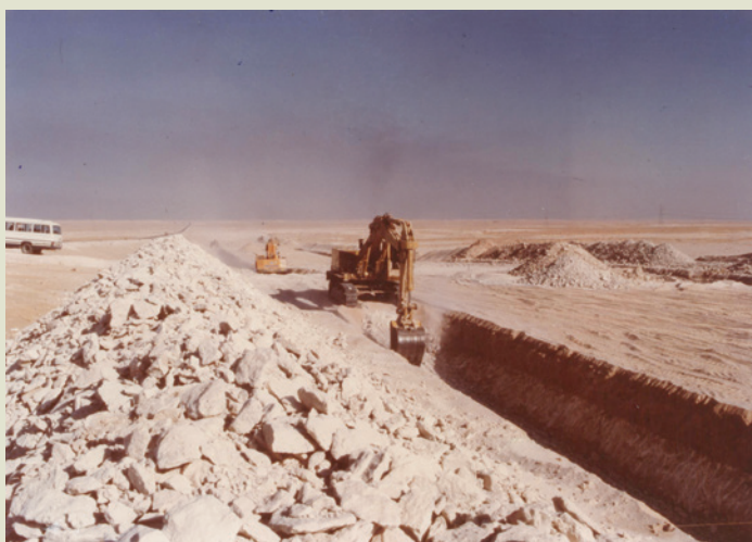
沙烏地亞德輸水管工程在黃沙滾滾的沙漠中作業。
