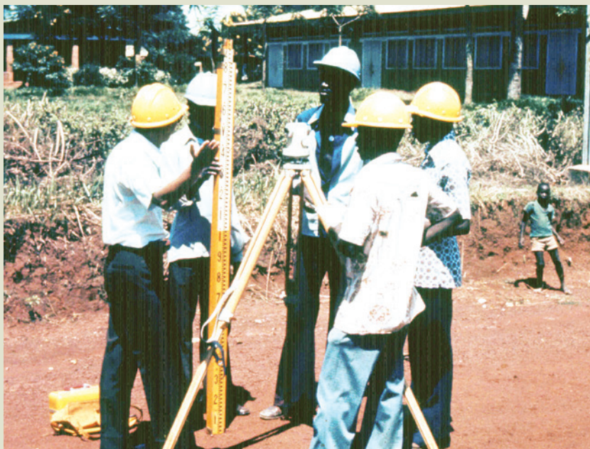
中非公路工程技術組指導當地技術人員進行測量作業。
