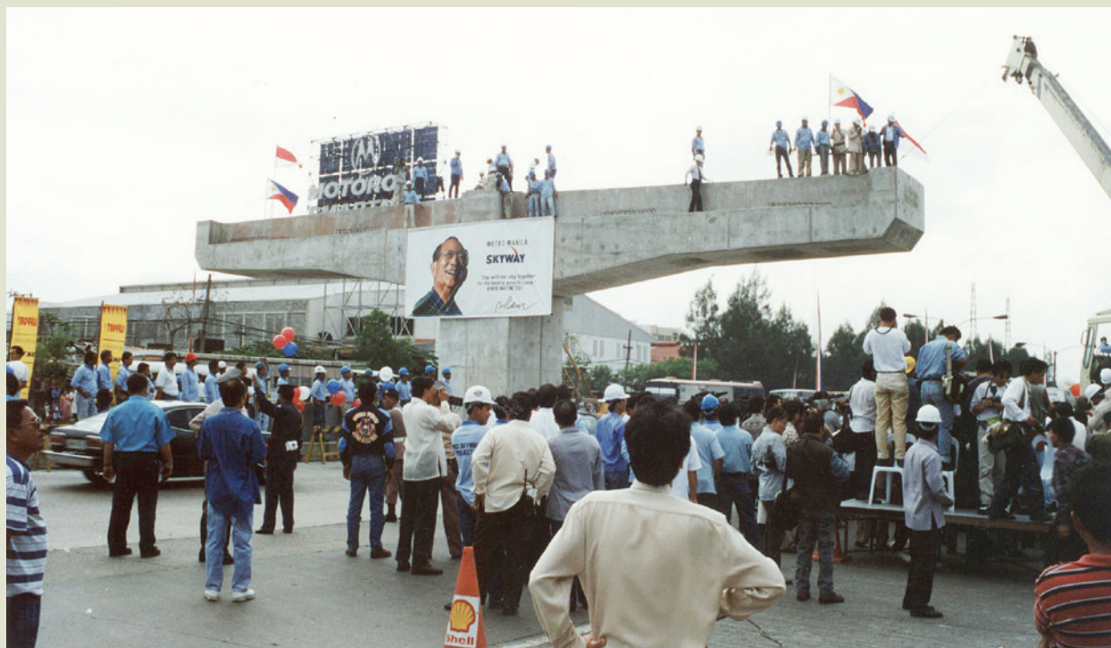
馬尼拉高架道路的施工特色是帽樑可旋轉，維護道路交通。
