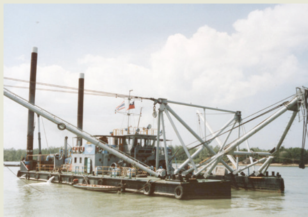
泰國南部北大年漁港挖泥工程。
