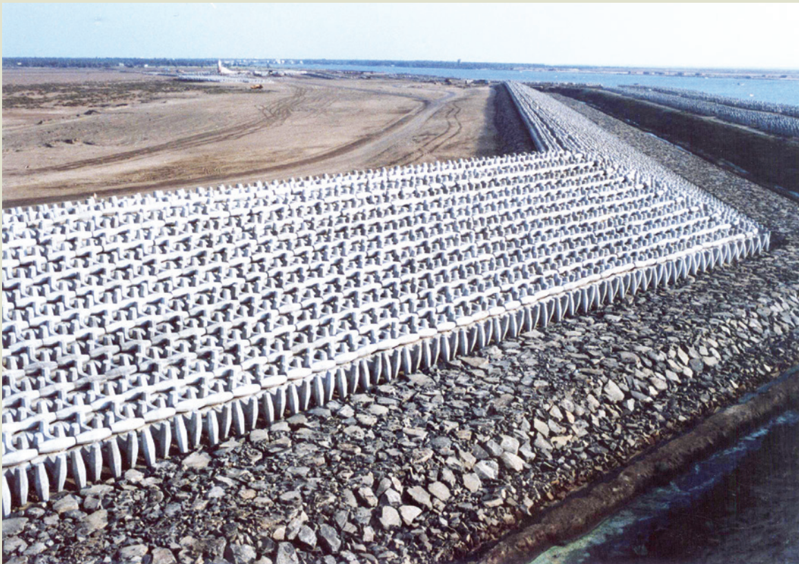
埃及羅西塔海堤工程。
