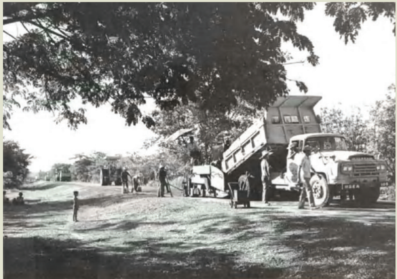
早期的泰國高級公路施工。
