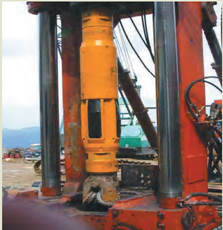
雪山隧道第1號豎井工程由榮工引進的昇井工法導向鑽孔系統。
