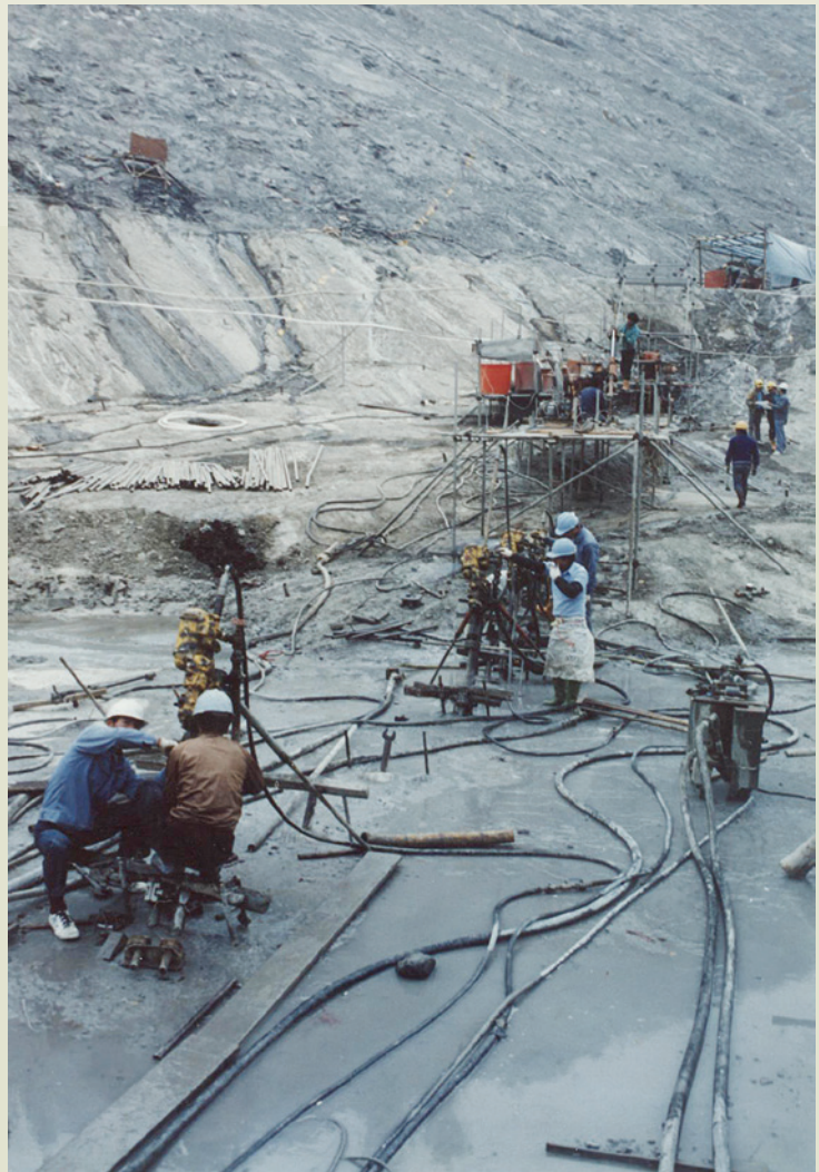
基礎工程隊的大壩壩基灌漿作業。
