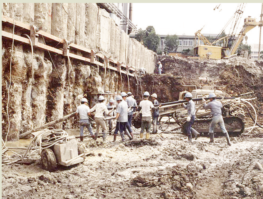
基礎工程隊的地錨施工。
