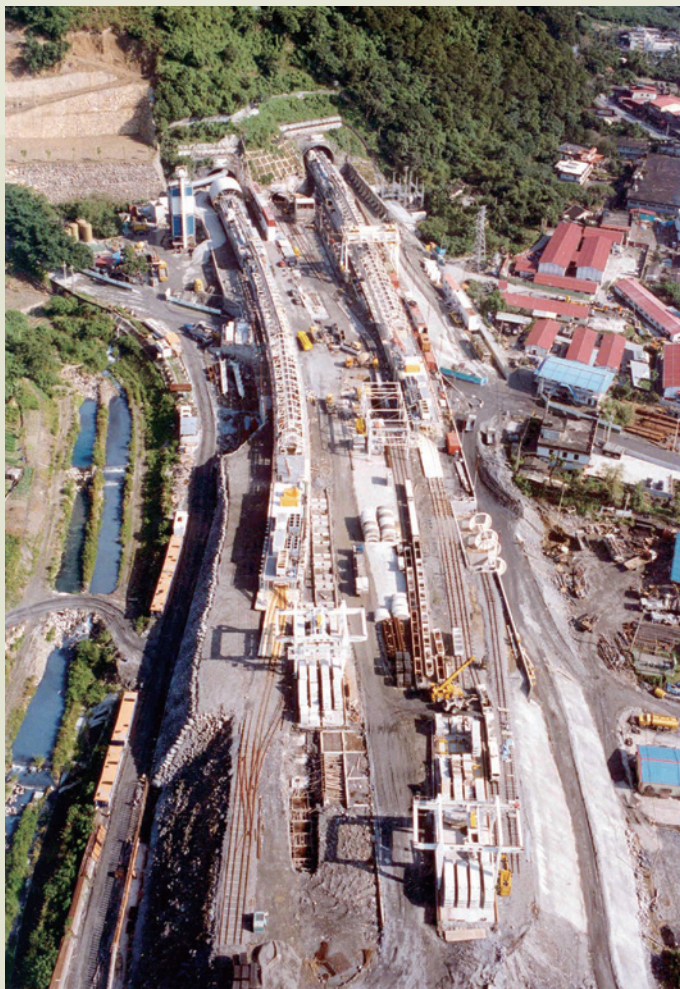
榮工引進隧道全斷面鑽掘 (TBM) 工法，進行雪山隧道施工。
