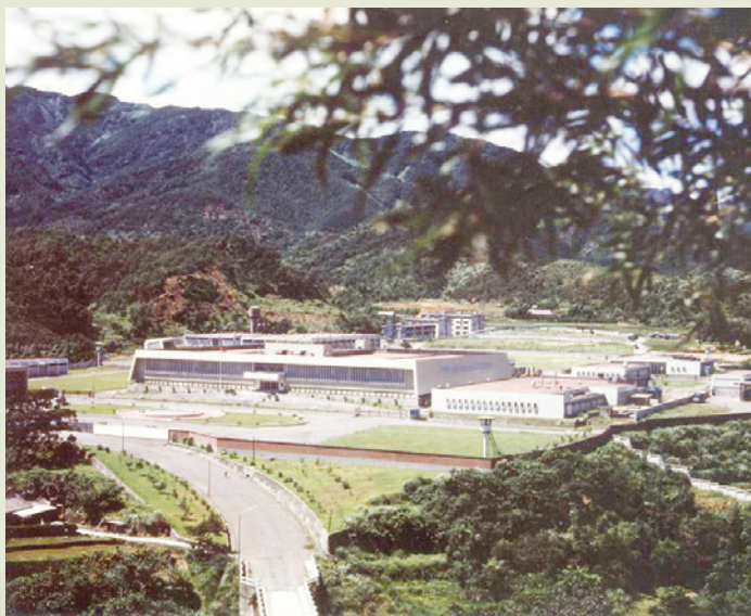
建築隊興建之中央印製廠安康廠。
