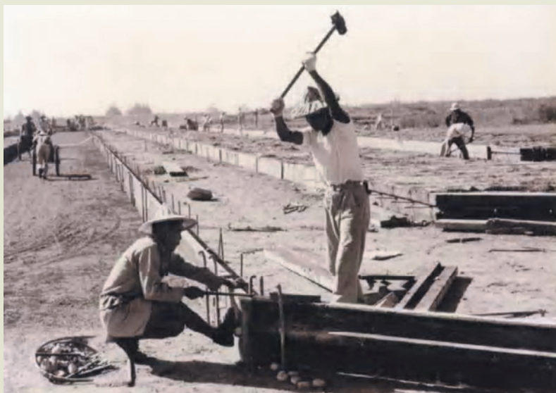
屏東機場擴建工程的人力施工。
