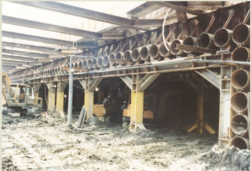
榮工引進、使用於高雄博愛地下道的管幕工法。
