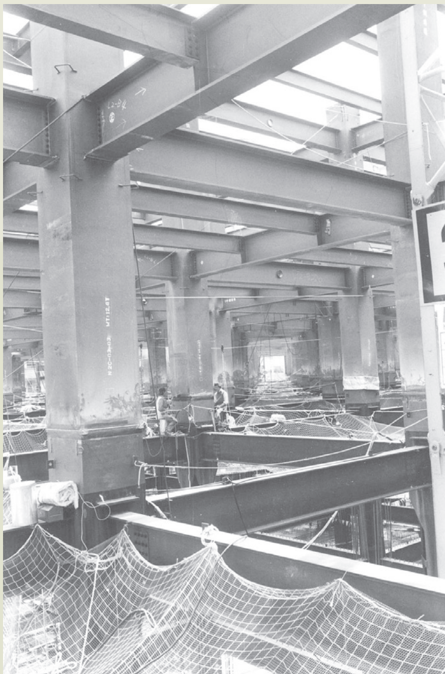
機電工程隊在臺北榮總更新計畫工程的鋼構作業。
