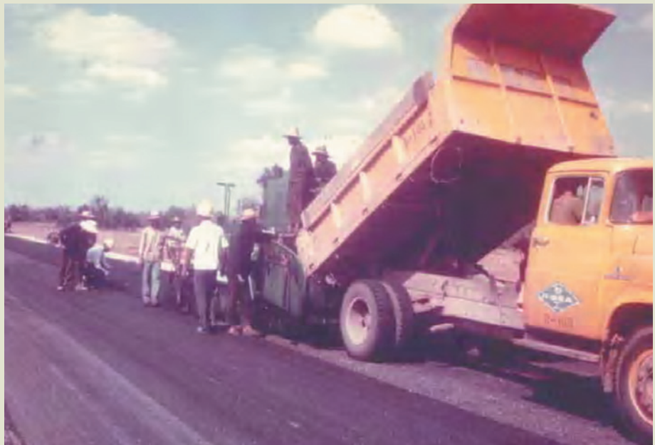
路面工程隊弟兄在國內學技術，也有機會到國外做工程，圖為泰國道路工程施工。
