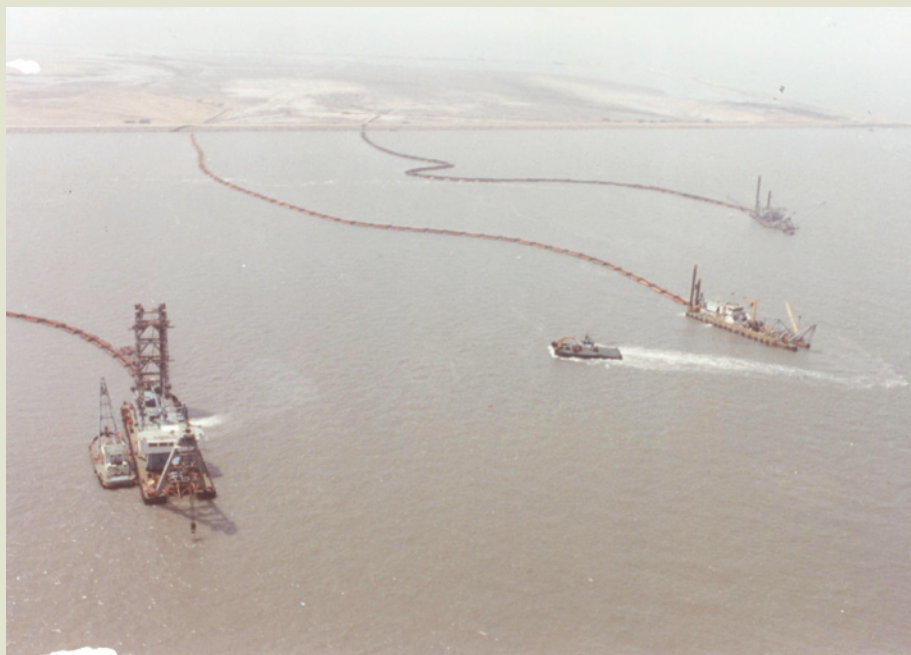
浚渫工程隊的挖泥船在彰濱工業區鹿港區進行抽砂填土作業。
