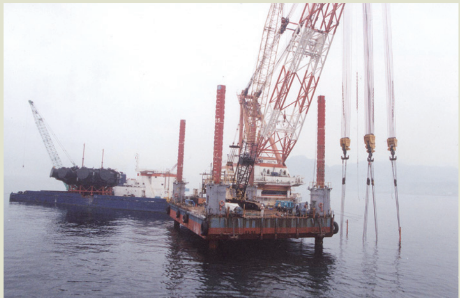
榮工承攬台電核四循環冷卻水出水道工程，啓用多項新工法，圖為排水頭J型管海上吊裝作業。
