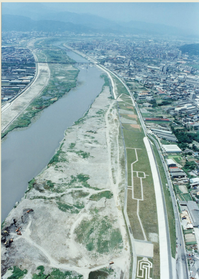
大臺北防洪計畫的樹林堤防。
