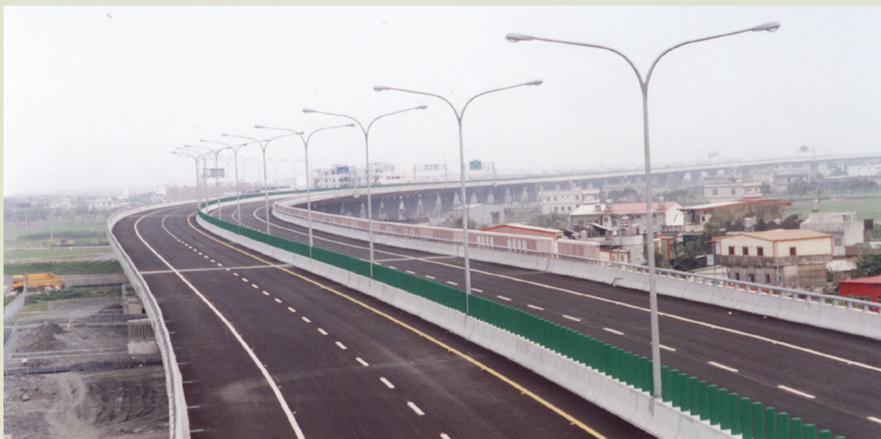
北宜高速公路頭城段蘇澳工程。
