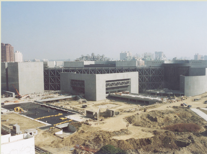
高雄國立科學工藝博物館工程施工。
