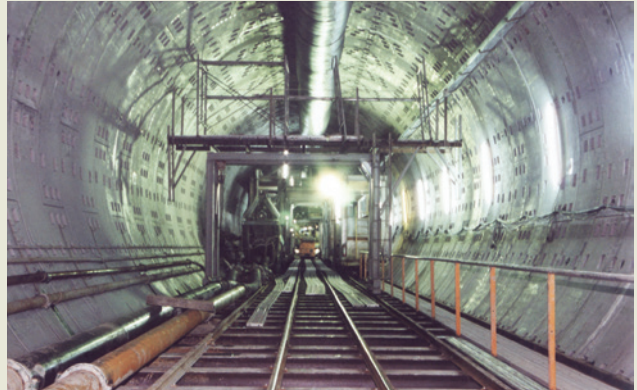
台電龍門計畫循環冷卻水出水道海底潛盾隧道。
