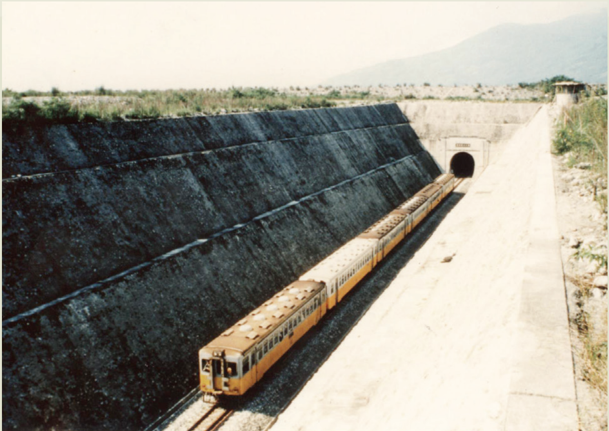
東線鐵路拓寬工程榮工完成溪口及光復河底隧道，杜絕鐵路橋因河床不斷淤高所產生之行車問題。
