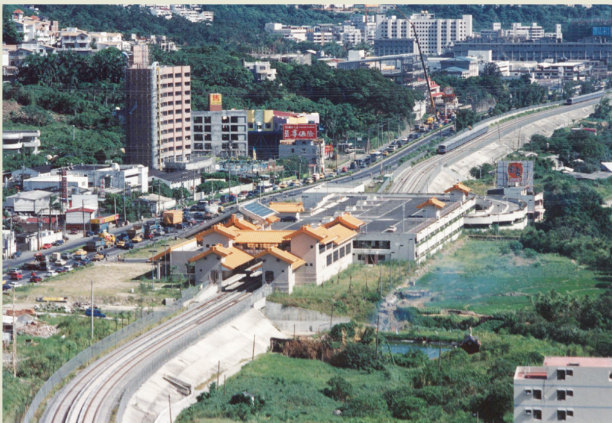
臺北捷運淡水線紅樹林站及路堤。
