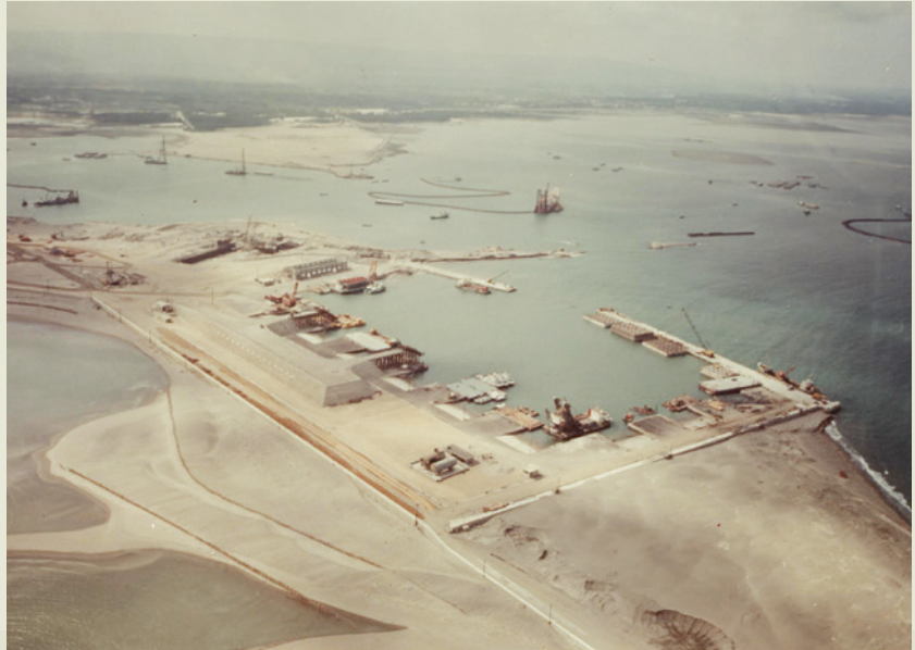
臺中港是榮民弟兄從一片沙灘中建設起來的人工港，圖為沉箱渠內的沉箱製作。
