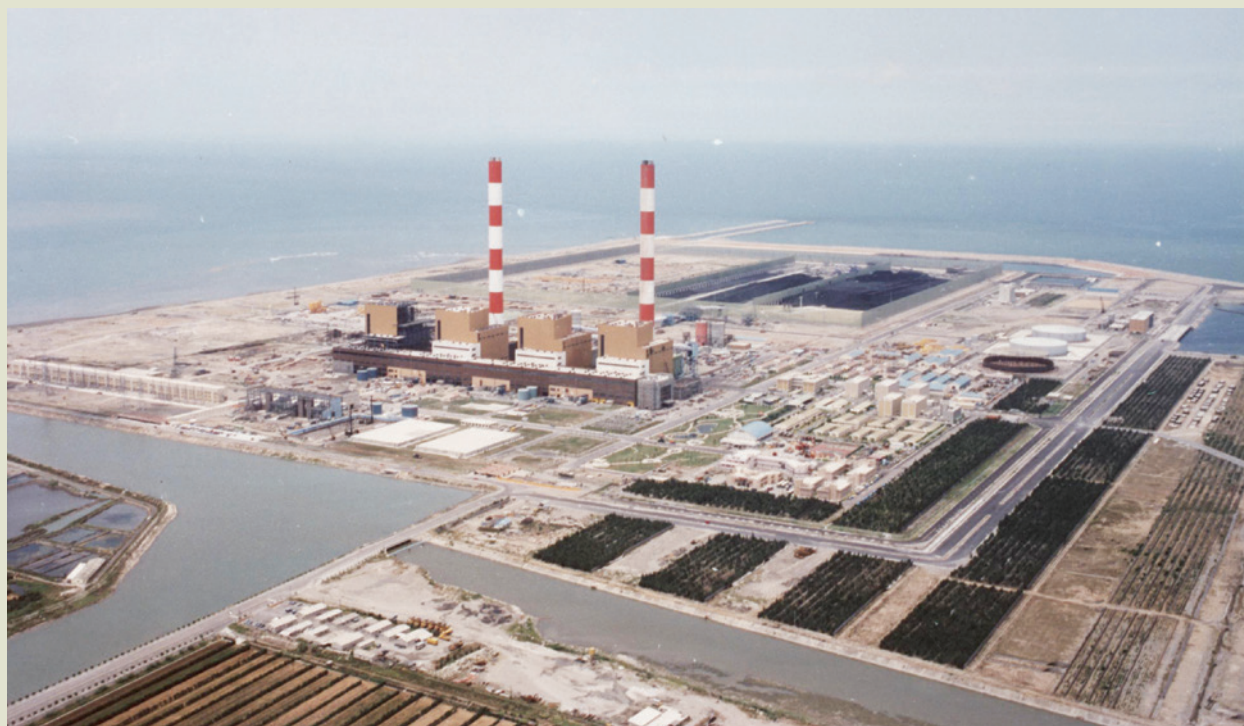
臺中火力發電廠完工初期鳥瞰。
