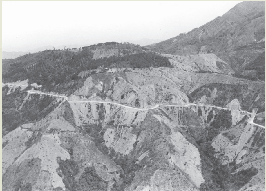
北部橫貫公路施工的艱鉅，不比中部東西橫貫公路遜色。
