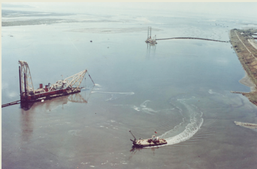
榮工挖泥船團分散在高屏溪出海口，填築林園石化工業區。
