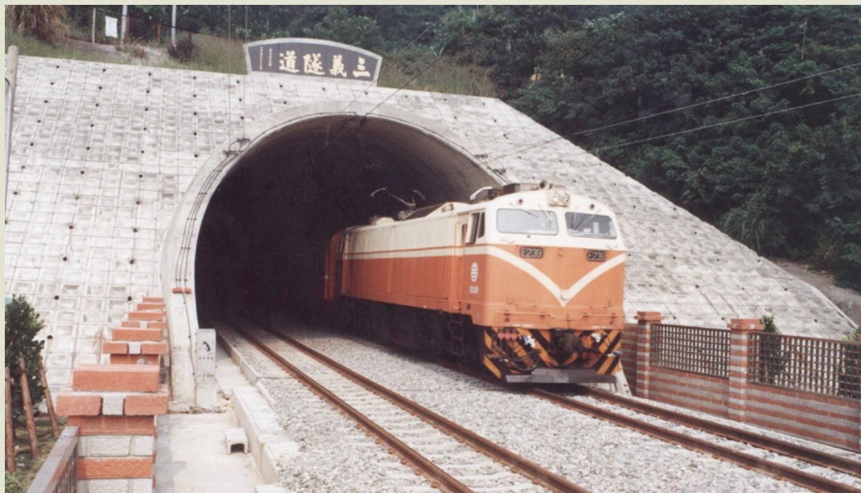
鐵路西部幹線三義隧道完工通車。
