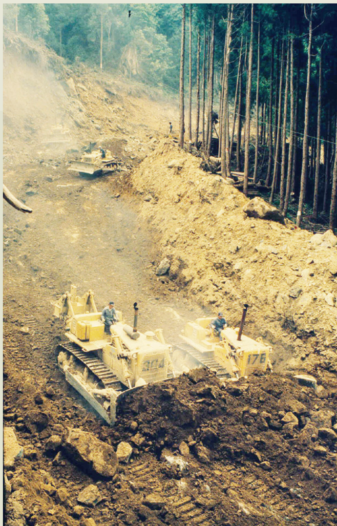
新中橫公路施工一景。
