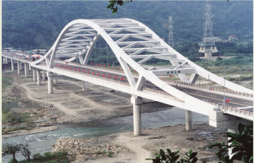
國內首座連續繫索鋼拱橋—桃園崁津大橋。
