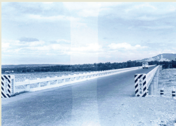
榮工早年施工完成的后豐大橋。
