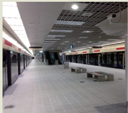
臺北捷運信義CR283標工程。
