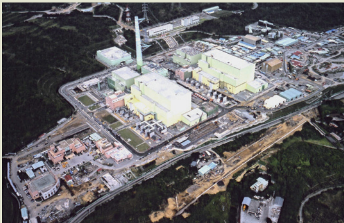
核四第一、二號機廠房工程。
