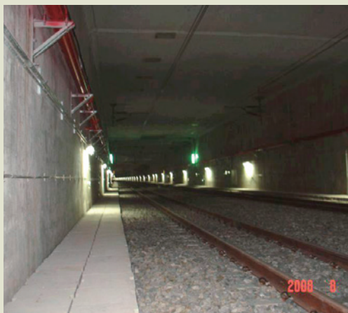
臺鐵南港專案南港客車場隧道工程。
