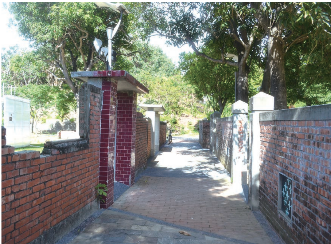
▲水交社公園結合舊建築遺址，保留舊巷道。
