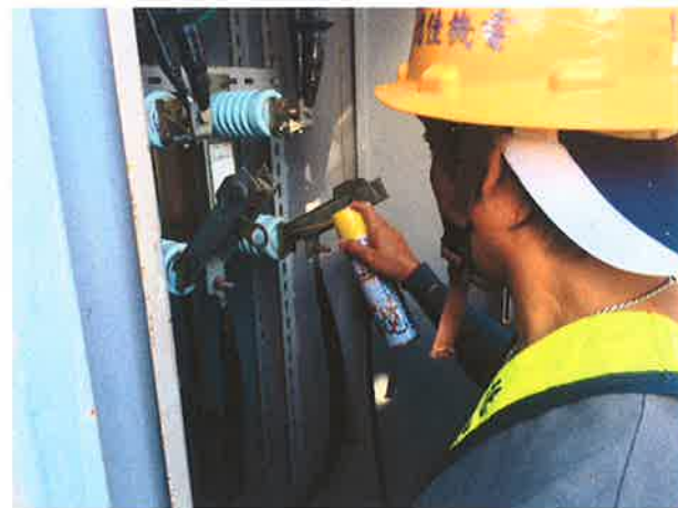
說明：DS 機械結構潤滑，記錄照片。
