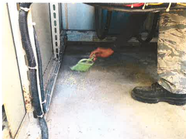
說明：箱體周圍環境清潔維護，記錄照片。
