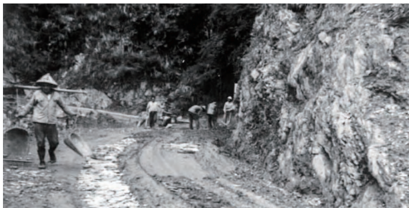
↑ 56年台8線 152K+400-500 路面搶修情形。
