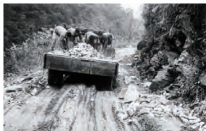
↑ 56年台8線153K+600-700運塊石卸車情形。
