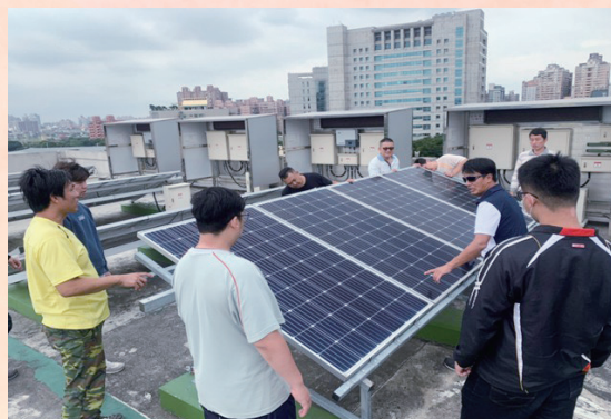
108 年職業訓練中心水電能源工程師班學員安裝太陽能板實習情形。
