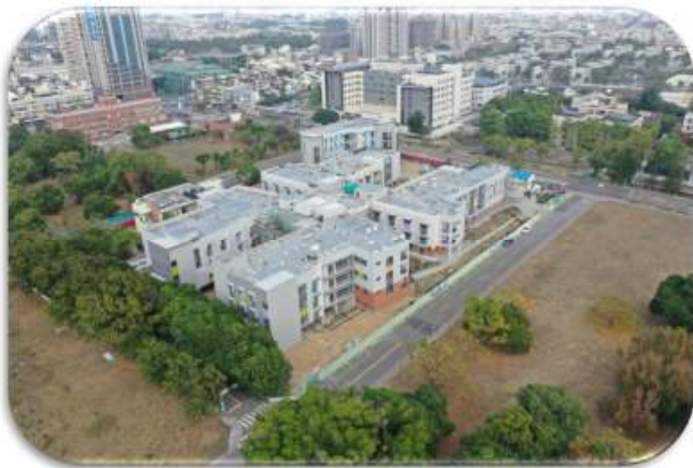
臺南榮家新建工程施工現況
