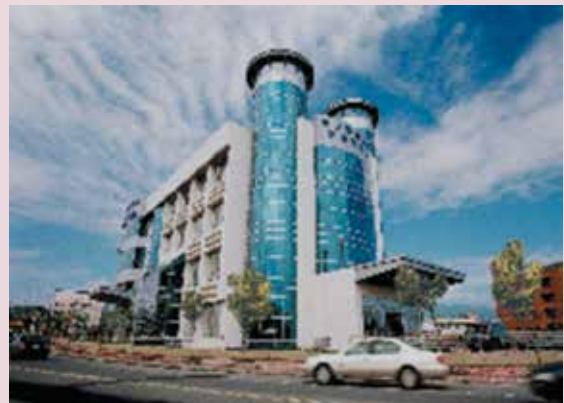
市區門診部91年11月完工。
