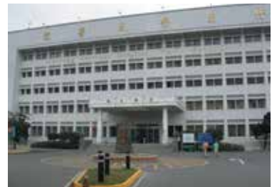
新竹分院門診大樓現貌。
