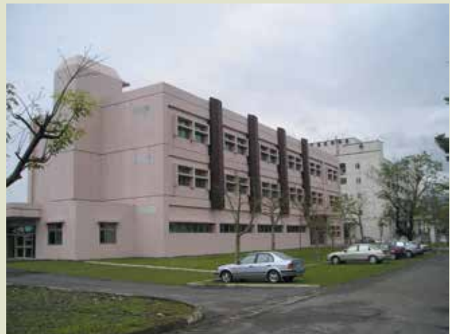
第4期醫療網全新完工之負壓隔離病房大樓計有地下1層及地上3層。
