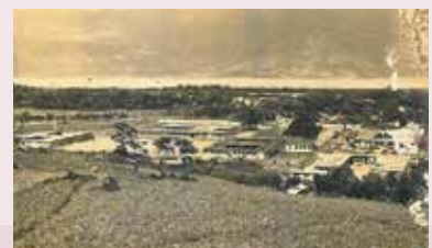
由院區後山拍攝本院全景照片。
