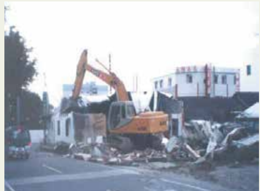
停車場、資源回收屋進行施工。
