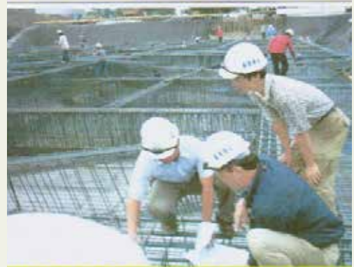
徐弘院長（左1）至工地瞭解工程進度。
