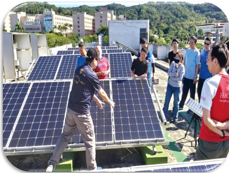
職訓中心太陽能光電班教導學員如何安裝太陽能板
