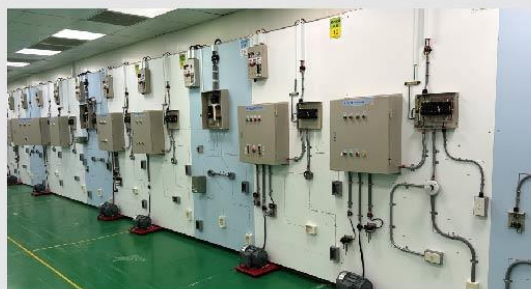
勞動部「室內配線乙、丙級」技術士考場
