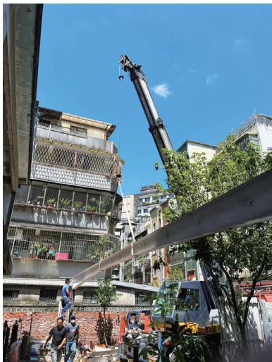
整建規模不小，還用吊車吊運大鋼梁。(圖／輔導會)
