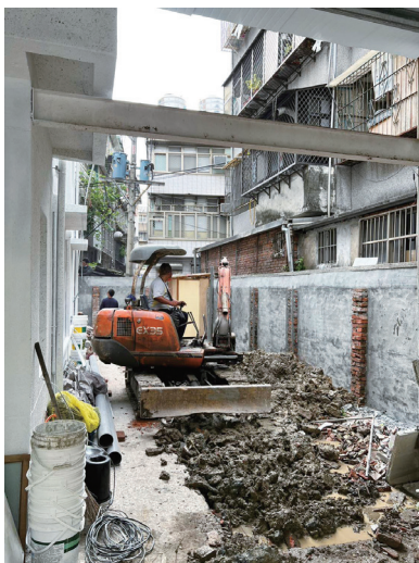
精舍建築旁的巷道原本凌亂，工作人員駕推土機整理。(圖／輔導會)
