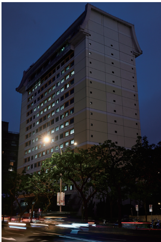
有時候，過了下班時間，輔導會還有同仁在加班，部分辦公室尚未關燈。（圖／林建榮）
