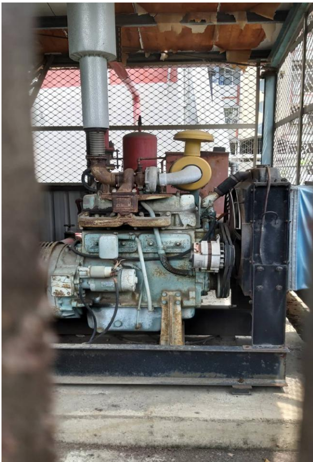
第 5 部 (1 號水塔下方)
